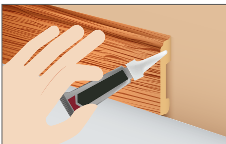
4. Utiliza pegamento instantáneo en las uniones de las juntas.
